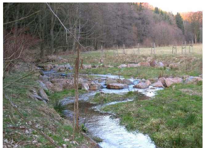
Geschiebesperre nach der Fertigstellung 2007
