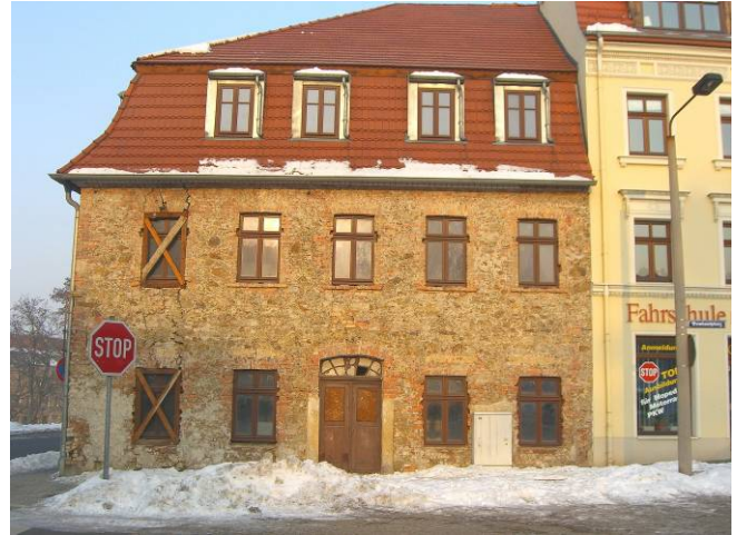
Fassadenansicht zum Demianiplatz vor der Sanierung
