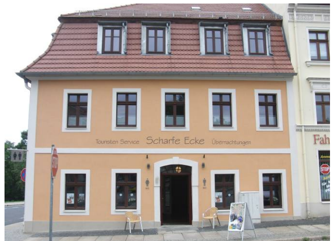
Fassadenansicht zum Demianiplatz nach der Sanierung
