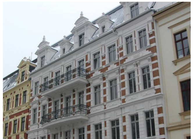
Straßenfassade nach der Sanierung
