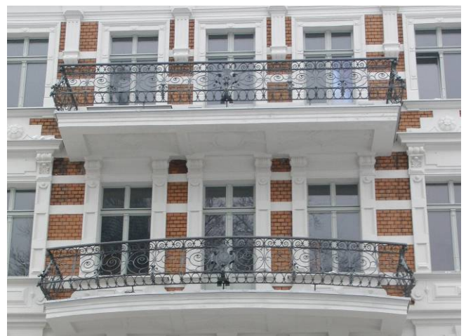
Detailansicht Balkon mit Kunstschmiede- geländer
